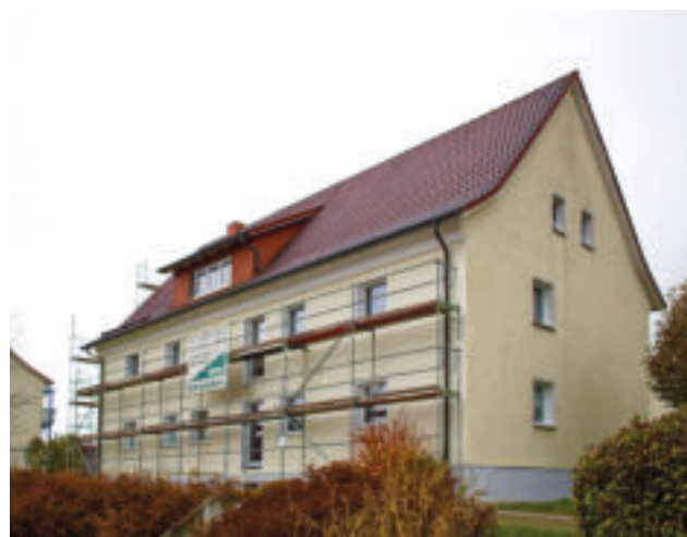
Straße der Jugend 26: Der geplante Balkonneubau an den einzelnen Mietwohnungen konnte erfreulicherweise im geplanten Umfang durchgeführt werden.
